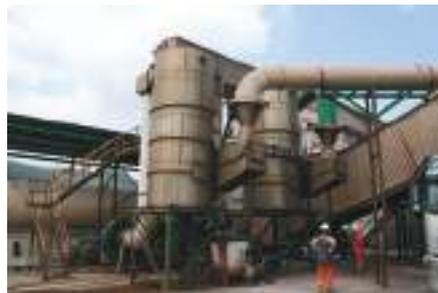
El principio aplicado es el de eliminar el polvo del aire haciendo uso de un ventilador aspirante que extrae el aire sucio de polvo, y lo conduce hasta elementos (separadores) en los que se produce la eliminación del polvo, expulsando después desde los mismos un aire exento de materia particulada (aire limpio).
