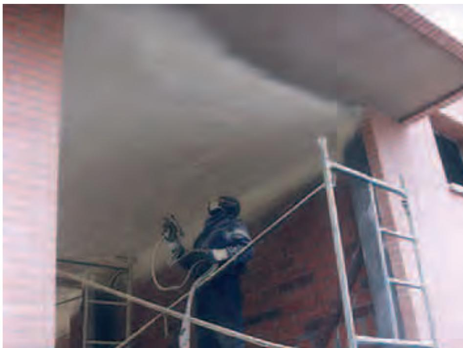
El proceso de proyección consiste en pulverizar, mediante la máquina citada, la mezcla de dos componentes altamente reactivos sobre la superficie a aislar, donde rápidamente expande y endurece. La aplicación se realiza en sucesivas capas, hasta alcanzar el espesor final de aislamiento deseado.
