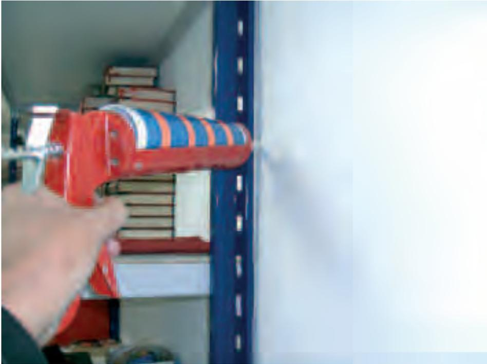
Normalmente se presentan en forma de cartuchos, a los que una vez perforados se les enrosca la boquilla que se corta en forma de bisel al tamaño del cordón que se desea para cada trabajo. El cartucho así preparado se introduce en una pistola que puede ser manual o neumática.
